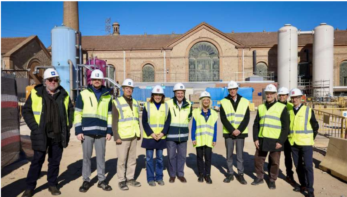
Foto de familia de la visita de Silvia Paneque a las obras de ampliación de la potabilizadora del Besòs / GENERALITAT
