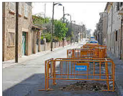
Las actuaciones ya se han iniciado.
