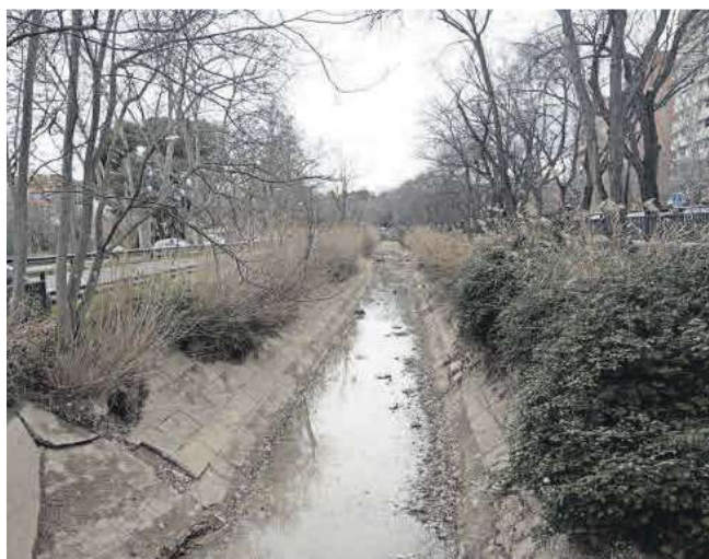
El Canal se vacía dos veces al año para su limpieza y mantenimiento.
